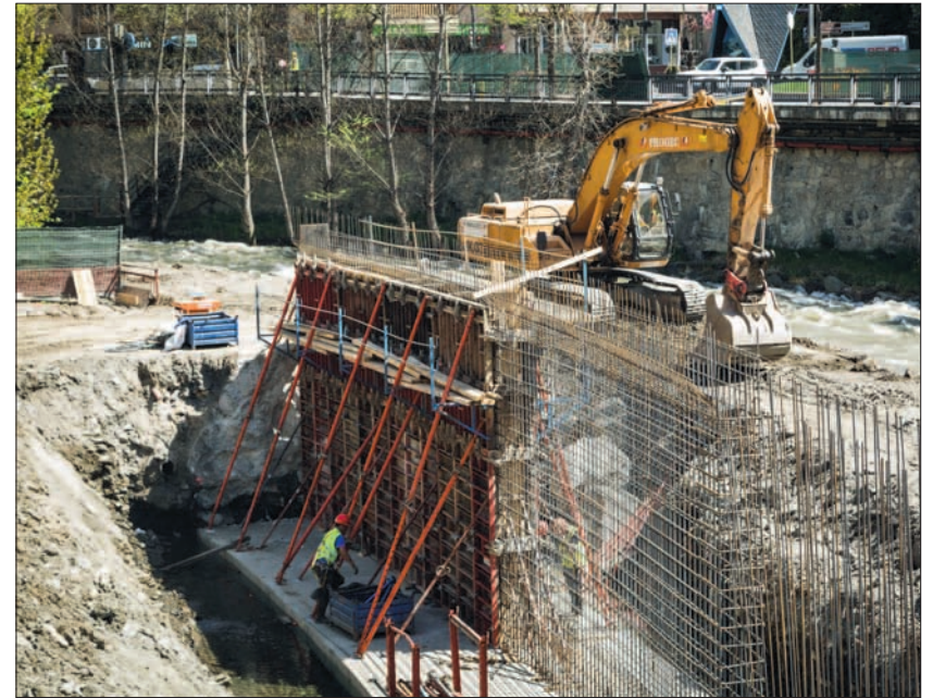
►► Operaris treballant en les obres del vial lauredià.
