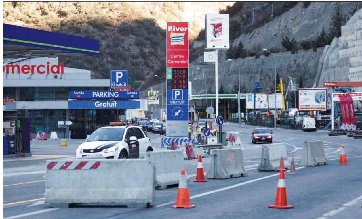
►► Vista de les obres de construcció de la rotonda a l'alçada del River.
