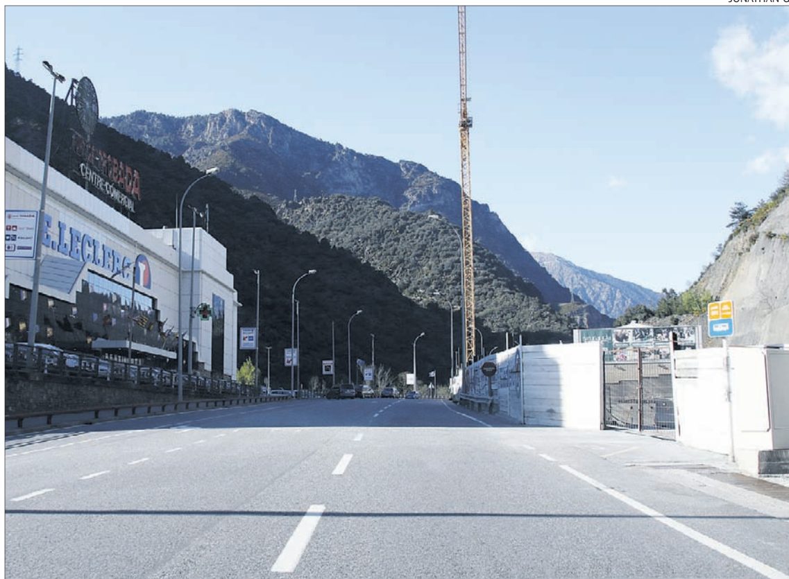
La CG-1 a l'altura del Punt de Trobada abans que l'executiu prohibís el gir a l'esquerra.
